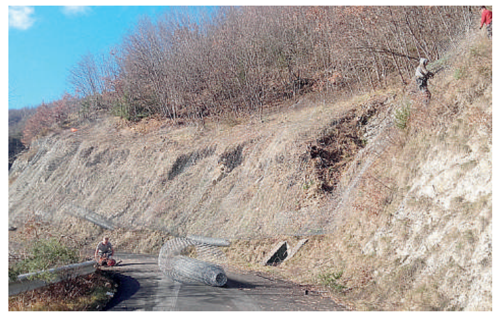
Gli interventi per mettere in sicurezza la strada di Pradovera
